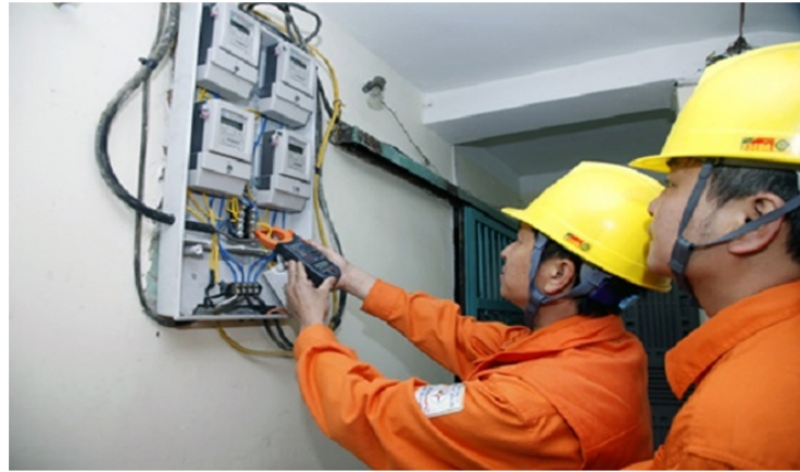
Hình 5. Sửa chữa điện tại nhà các hộ dân
