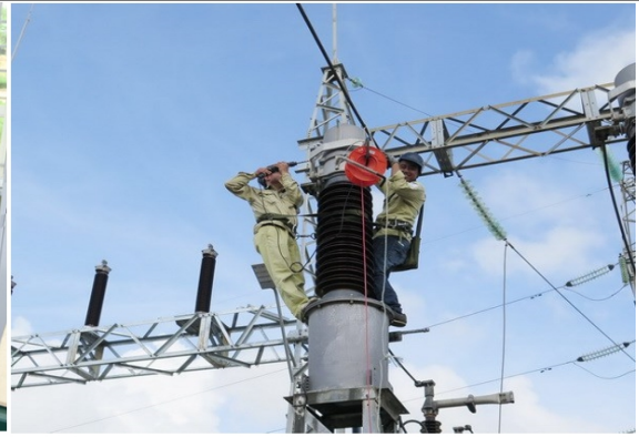
Hình 2. Lắp đặt đường dây cung cấp điện
