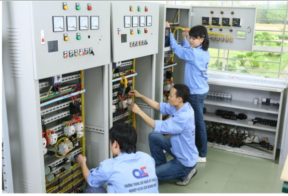
Hình 1. thợ điện thực hiện các công việc tại nhà máy
